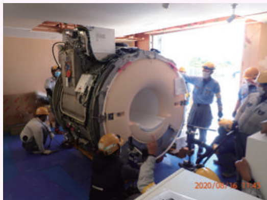
撮影室内機器設置位置まで搬入
