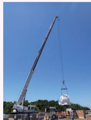
新機器クレーンで移動中
